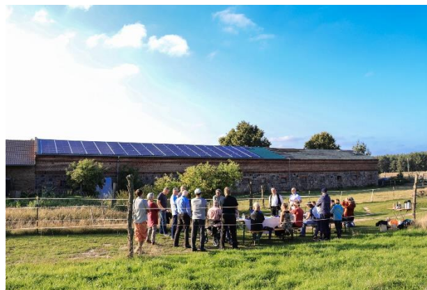
Quelle: Heiko Bansen, Einweihung der Süd-Ost PV-Anlage Arensnest
